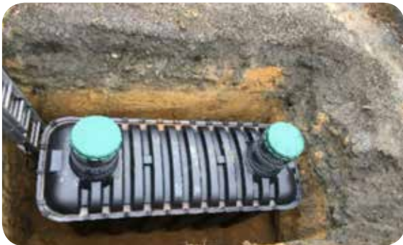
Instalación del tanque en el fondo de la excavación
