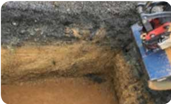
20 cm de arena en el fondo de la excavación
