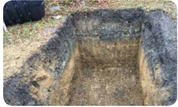
Realización de la excavación
