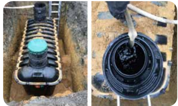
Relleno con arena estabilizada con nivel constante (relleno simultáneo con agua limpia)
