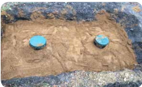
20 cm de arena alrededor del depósito
