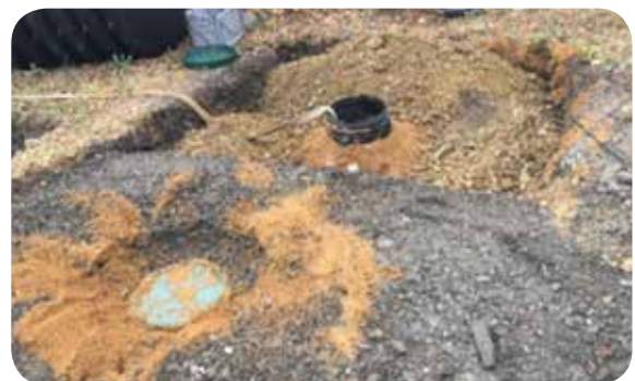
Acabado final en tierra vegetal o relleno
