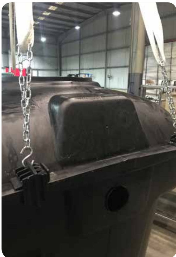
Coloque los ganchos y las cadenas en el clip
