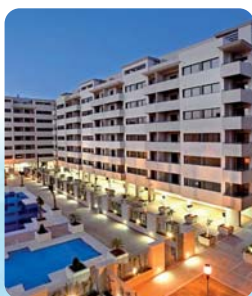
Residencial Litoral Beach. 368 viviendas (Málaga).
