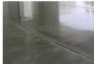
Juntas de pavimentos interiores transitables
