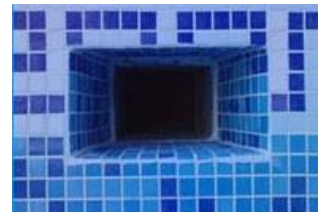
Pegado y sellado entre elementos de piscinas
